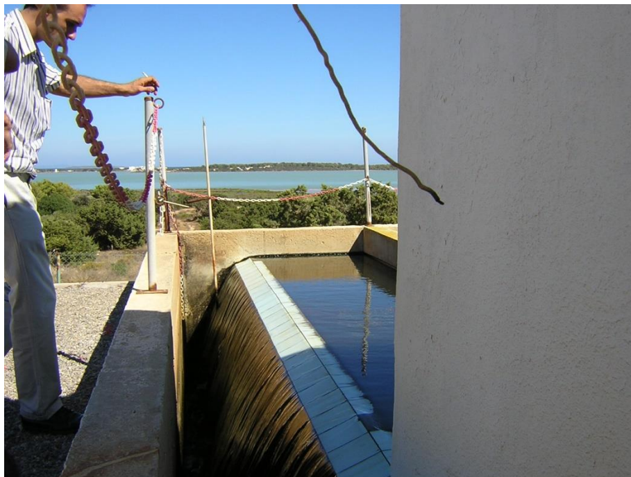
Imagen 2. Salida del efluente de la EDAR.
