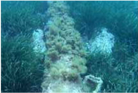
Imagen 5. Lastre final del tramo (cota -11 m)
