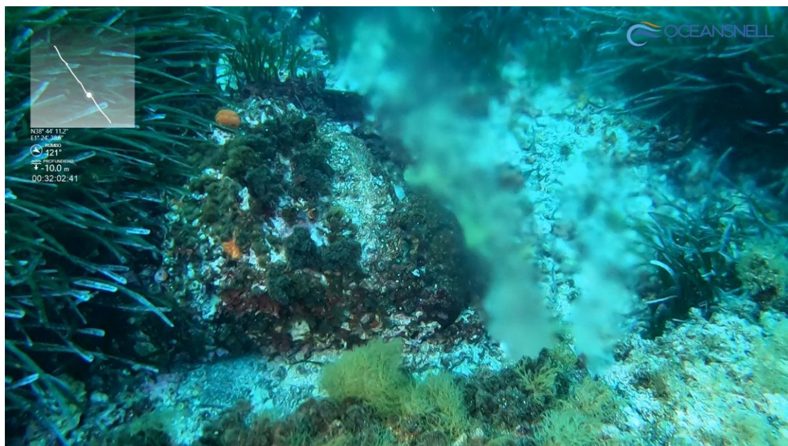
Imagen 22: Fuga en la conducción.
