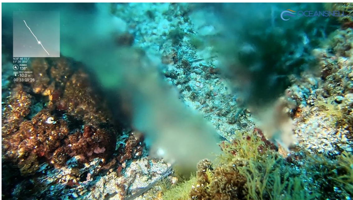
Imagen 20: Fuga en la conducción.
