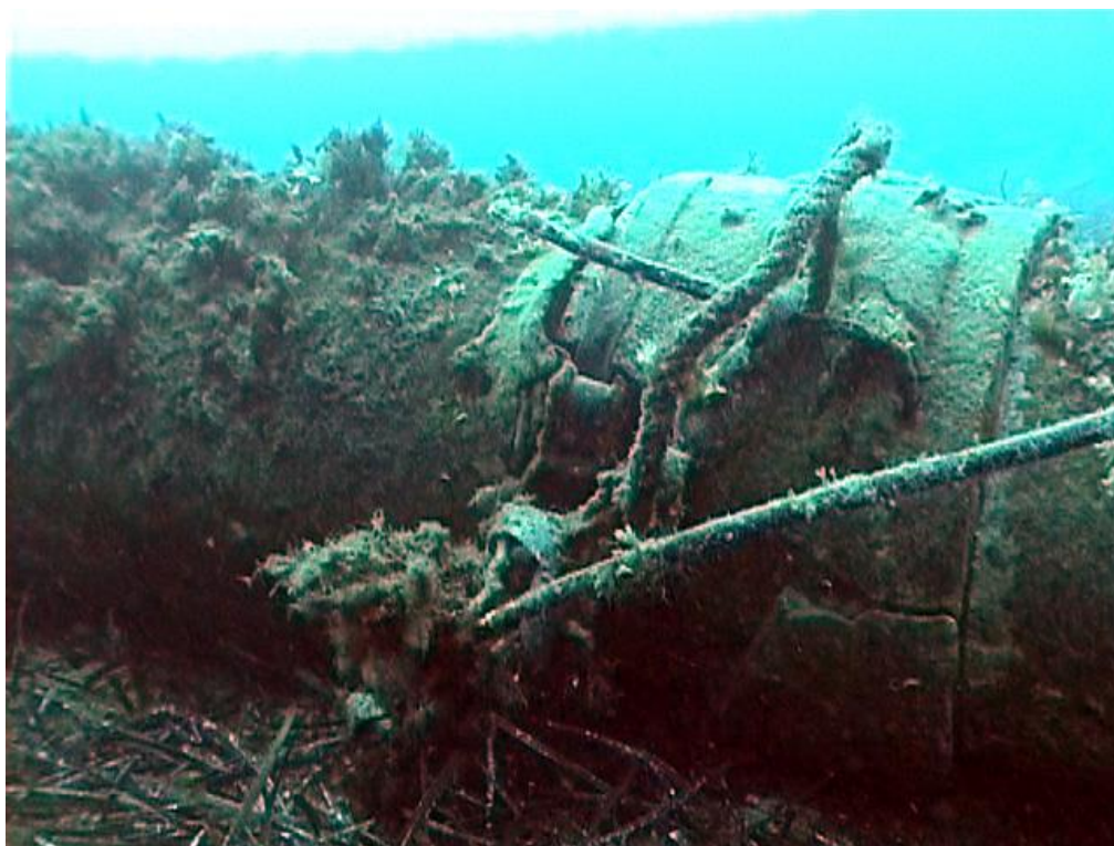
Fotografía 18. Cota -15 m. Brida de fibrocemento rota y mal reparada
