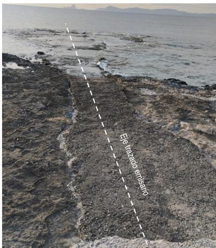
Imagen 13 Prof = 0 m. Transición entre tramo terrestre y tramo marino del emisario actual. Se observa la protección de hormigón y el entorno completamente de naturaleza rocosa.
