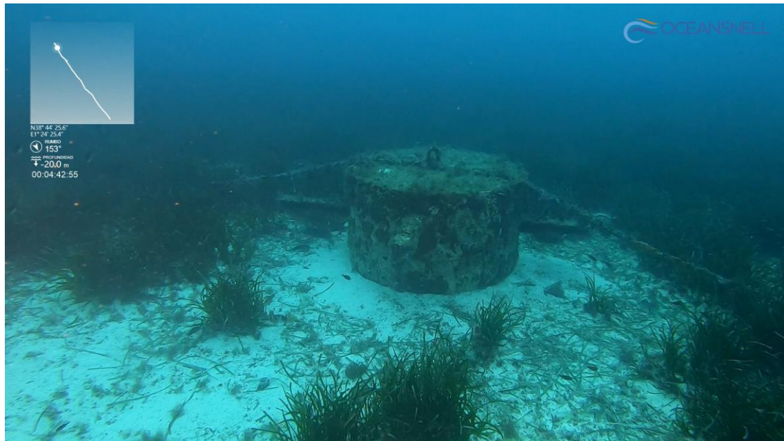
Imagen 4: Módulo antiarastre con cadena.
