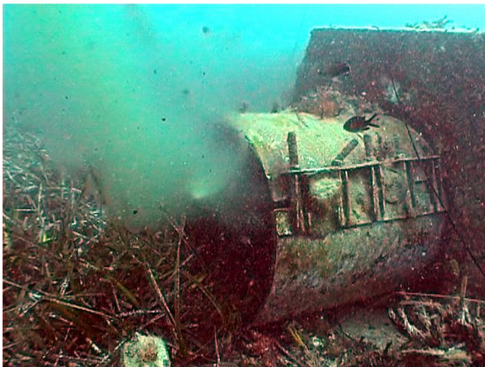
Fotografía 15. Cota -12 m. Rotura del emisario
