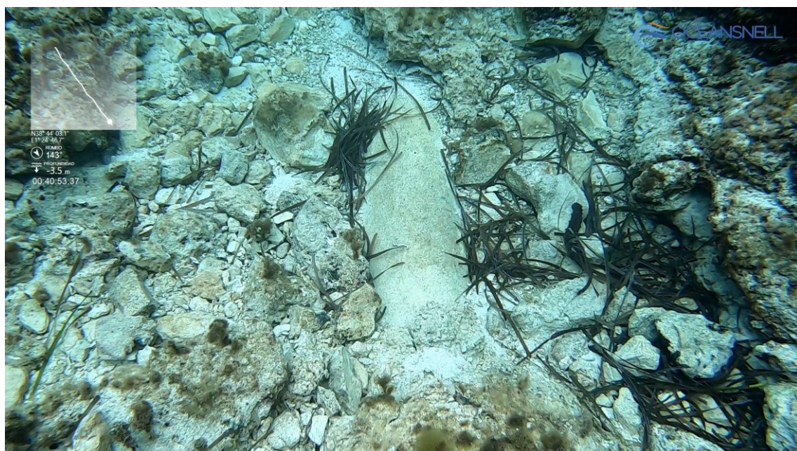
Imagen 24: Afloramiento de la conducción en zona somera.
