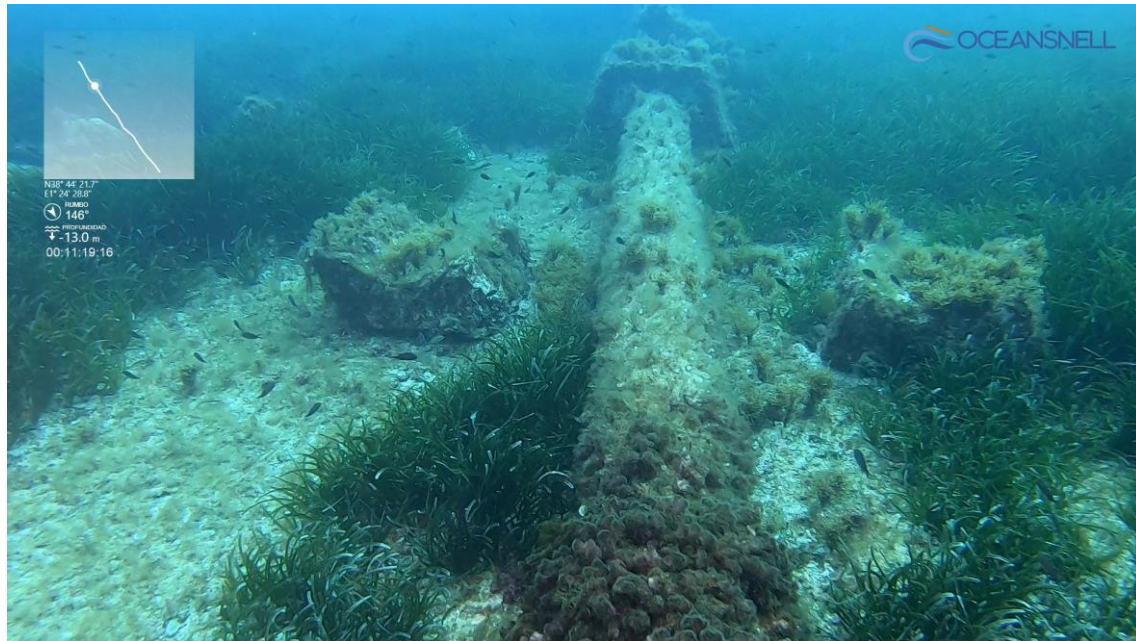
Imagen 11: Lastres junto a la conducción.
