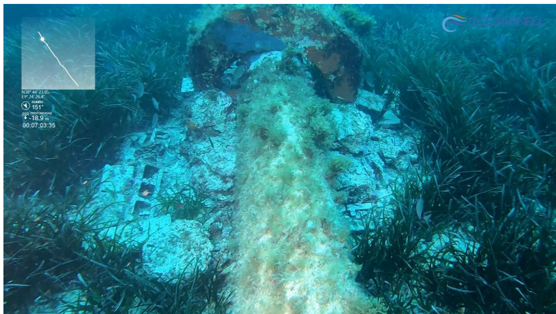
Imagen 8: Lastres disgregados.
