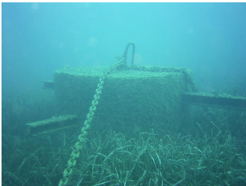
Arrecife antiarastre unido con cadenas para proteger la boca del emisario y los fondos de Posidonia adyacentes.
