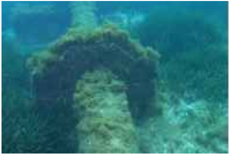
Imagen 9. Lastre final del tramo (cota -12 m)
