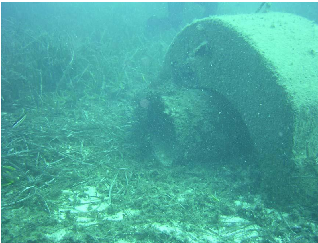
Boca del emisario situada a 21m de profundidad en pradera de Posidonia .
