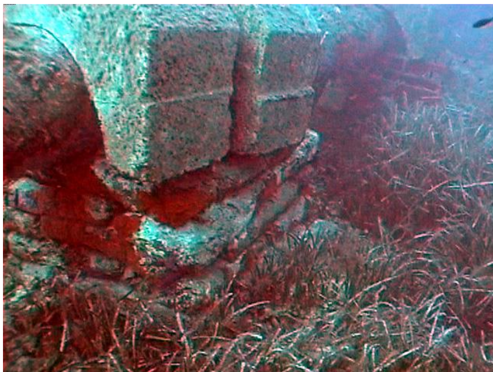
Fotografía 20. Cota -19 m. Pila de sacos con dos bloques sobre ellos
