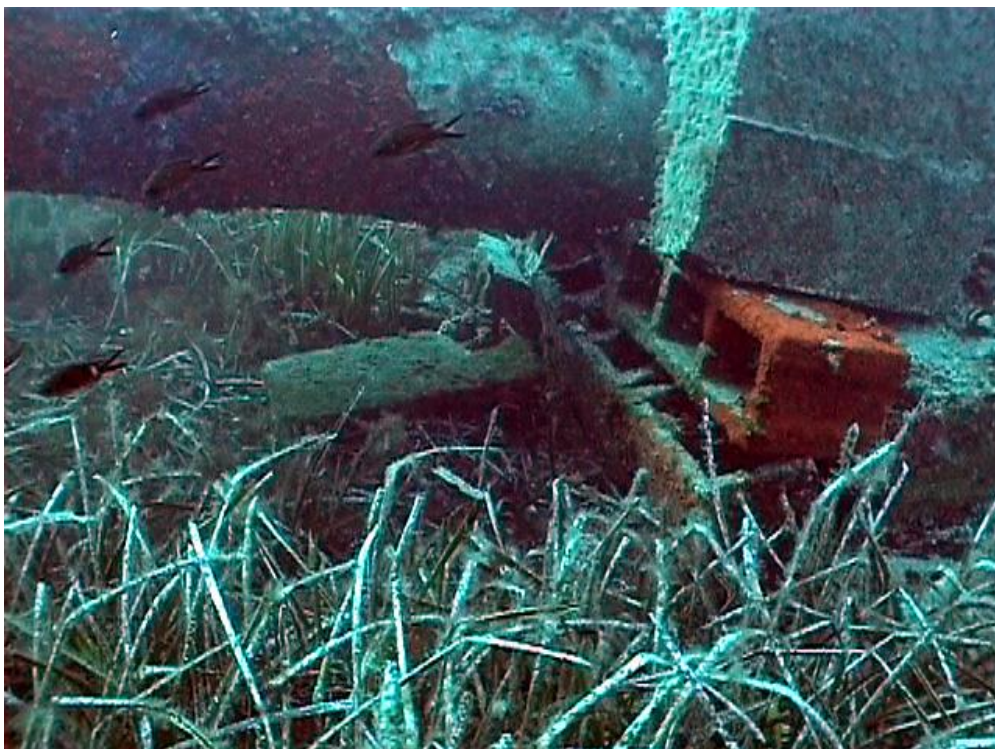
Fotografía 19. Cota -19 m. Pila de bloques y hormigón en mal estado
