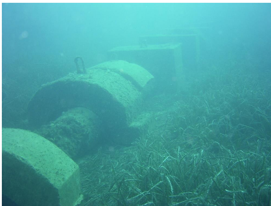
Emisario sobre Comunidad de Posidonia oceánica a 15 m de profundidad
