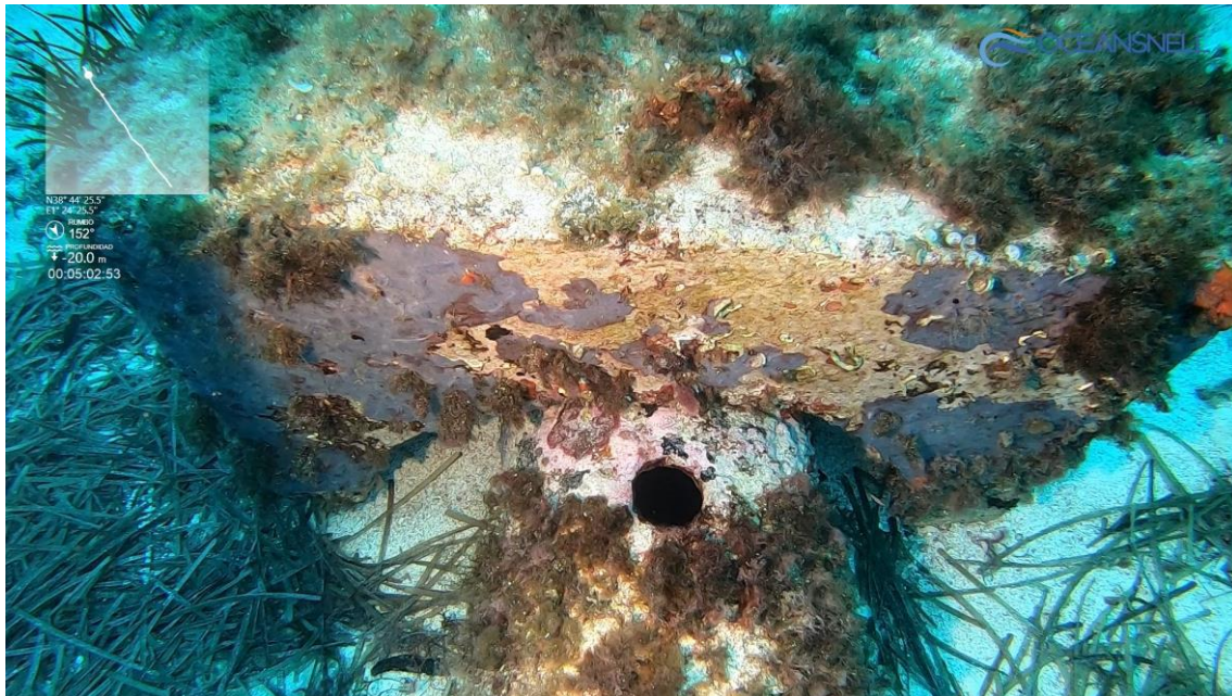
Imagen 6: Orificio difusor junto a lastre.
