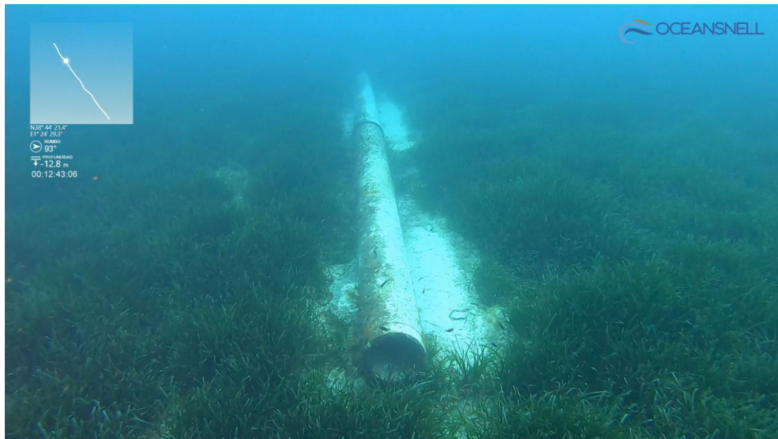
Imagen 13: Resto de conducción desconectada.
