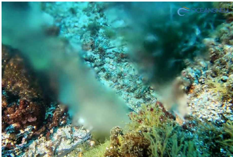
Imagen 7. Fuga 1 en junta PK 3+614
